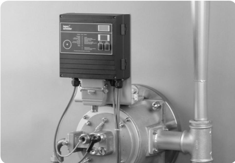
*BCU am Strahlrohrbrenner*
